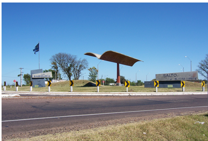
Figura 4.5: Monumento homenaxe a Eladio Dieste na cidade de Salto, feito coa técnica da cerámica armada. Foto: ©Tano4595 (cc-by-sa/3.0)
