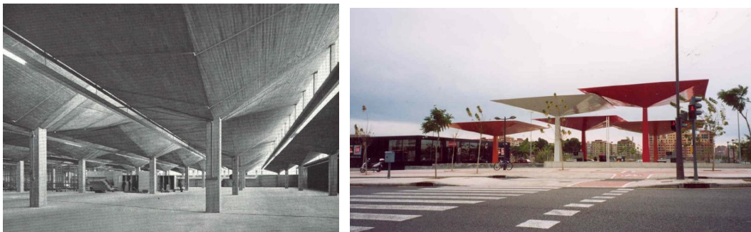
(a) Almacéns John Lewis, diseñados por Félix Candela, Mardell & Rosenberg e Yorke. Foto: ©Chris James (cc-by-sa/2.0 uk) (b) Estación de servizo diseñada por Norman Foster. Foto: ©Chesgv (cc-by-sa/3.0)
