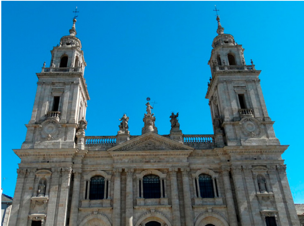
Torres de Nemesio Cobreros na fachada do Bo Xesús
