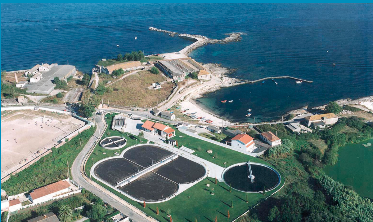
Estación de Depuración de Augas Residuais (EDAR) de Cangas do Morrazo
