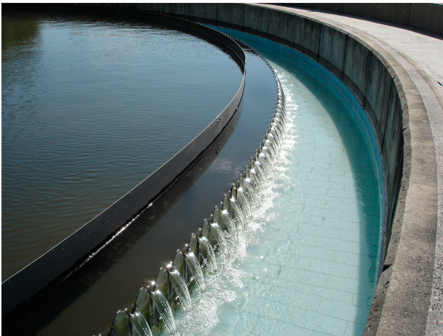
Saída do efluente secundario dunha EDAR
