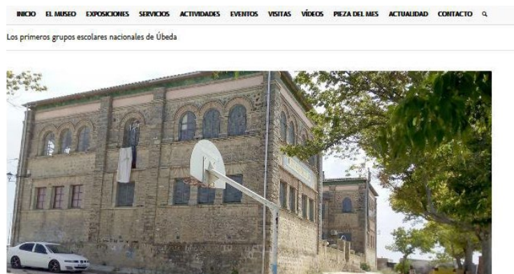
Figura 3. Edificios escolares: Los primeros grupos escolares nacionales de Úbeda (Jaén)
