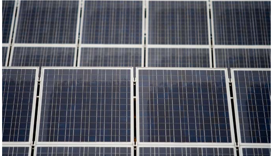
Imagen 97: Placas fotovoltaicas de silicio.
