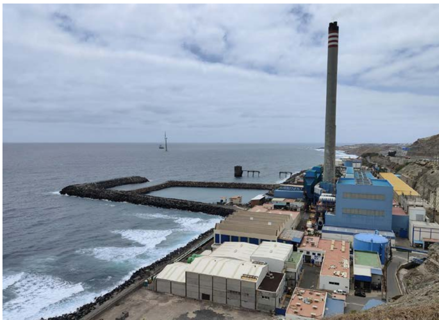
Imagen 17: Fotografía de una desalinizadora con su central térmica en la Isla de Gran Canaria.
