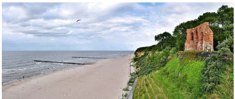
Imagen 48: Trzęsacz (noroeste de Polonia) en la costa del mar Báltico. Se observan las ruinas de una iglesia construida a principios del siglo XVI que fue destruida por el avance del mar.
