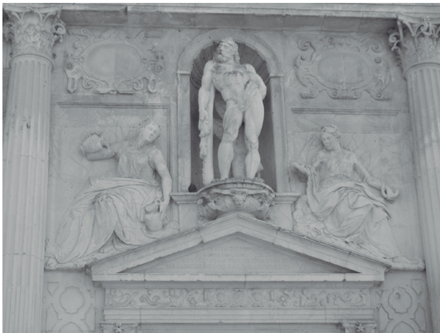
Fig. 5. Jerez de la Frontera, Cádiz. Casas consistoriales. Detalle de la fachada
