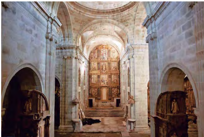
Fig. nº. 5.- Rehabilitación del templo. Vista general. . Fuente.- Archivo del IRCBCC.
