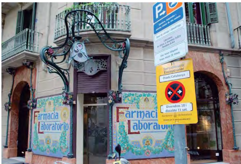
Fig. 5. Fotografía actual de la fachada de la antigua farmacia del Dr. Palomas. Ronda de San Pedro, 40 - Bruc, 8 de Barcelona. Fotografía realizada por la autora
