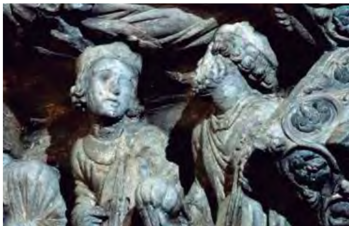
Fig. 2: Ancianos músicos en la arquivolta exterior del tímpano central donde se aprecian evidentes deterioros por humedades (eflorescencias salinas y consecuentes pérdidas de policromía). ©Fundación Barrié
