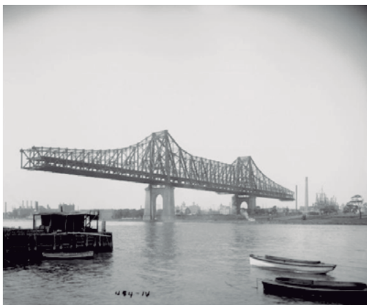
Fig.2. Construcción del puente. Se aprecia el proceso constructivo cantilever, en el que se iban añadiendo tramos en ménsula a un lado y al otro del vano rígido, siendo necesario el equilibrio de masas en ambos extremos volados
