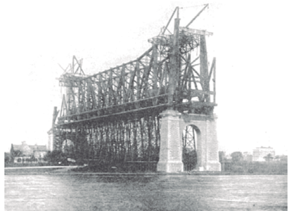
Fig.2. Construcción del puente. Se aprecia el proceso constructivo cantilever, en el que se iban añadiendo tramos en ménsula a un lado y al otro del vano rígido, siendo necesario el equilibrio de masas en ambos extremos volados
