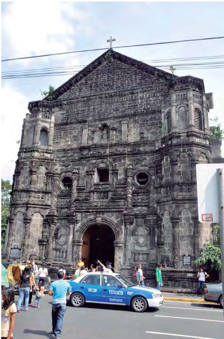
Figura 3. Filipinas. Malate. Iglesia de Nuestra Señora de los Remedios. Fachada principal. Estado actual
