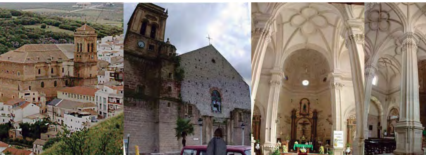
Figura 2. Instantáneas que muestran la configuración externa compacta, la fachada inacabada y la solución de los años 50 del siglo XX, la cabecera interior y las bóvedas y pilares de las naves. Autor: J. GUZMÁN
