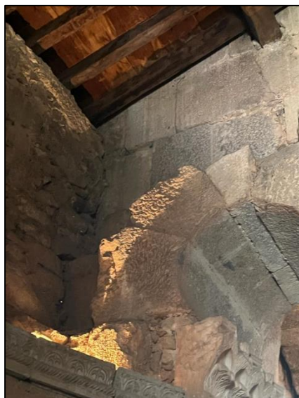
Fig. 7: Aspecto inacabado do interior de Montélios. Autoría propia.
