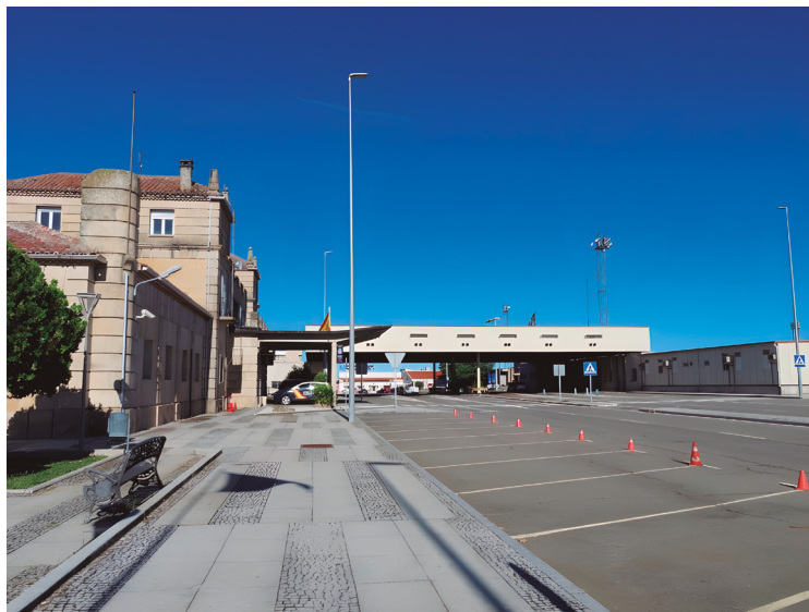
Figura 4.2. Paso fronterizo y aduana española en el enlace de la IP5 con la N-620
