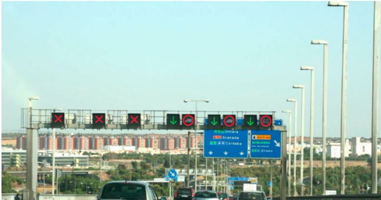
Figura 3.5: Sinalización con aspa-frechas de carrís reversibles
