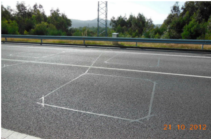
Figura 2.1 Detectores de lazo indutivo
