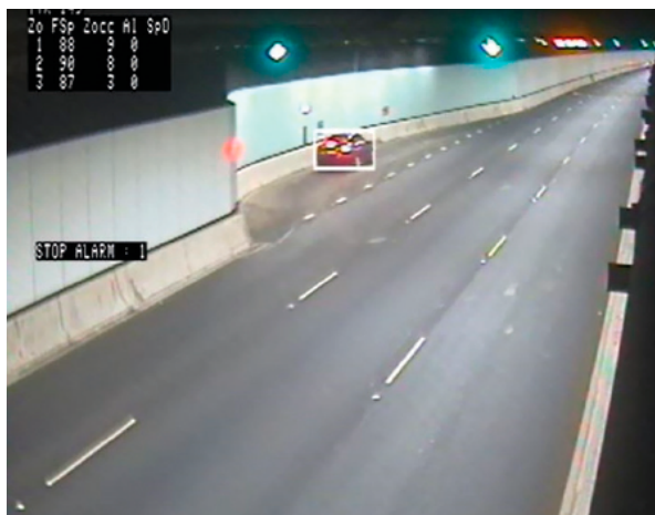
Figura 2.5 Sistema de Detección Automática de incidentes
