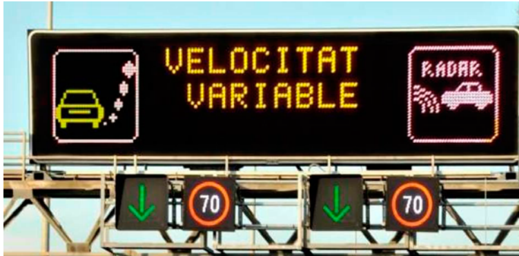
Figura 3.6: Sinalización de control de velocidade variable
