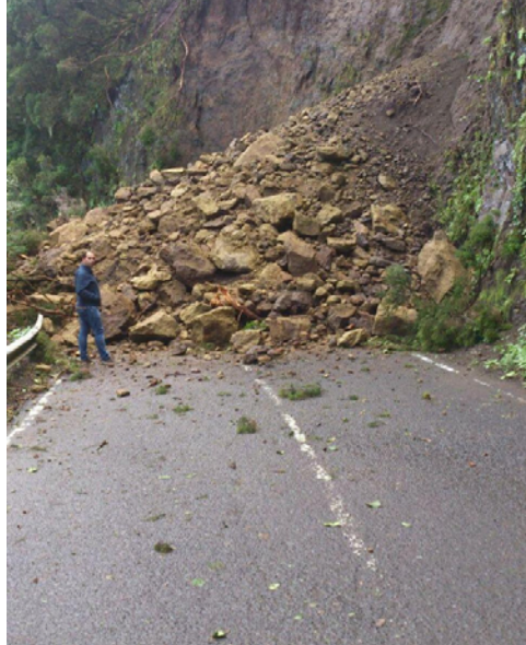
Figura 4.1: Desprendemento dun noiro en estrada
