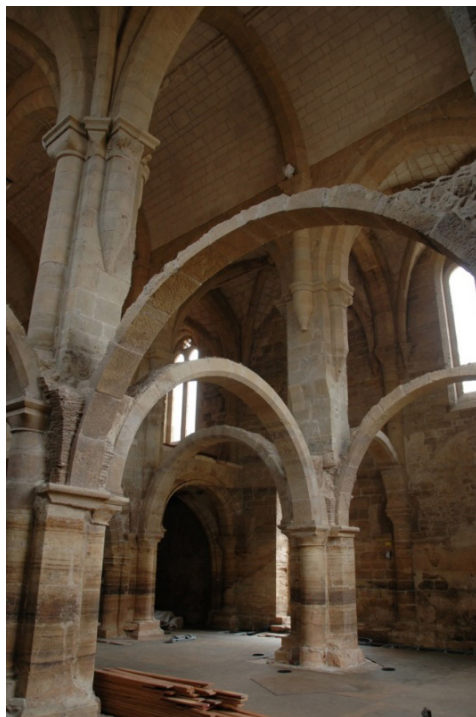
Fig. 4 - Igreja de Santa Clara-a-Velha de Coimbra.
