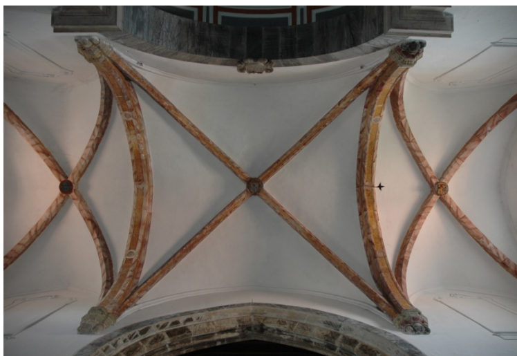
Fig. 3 - Igreja de São Francisco de Estremoz, Abóbada do transepto.
